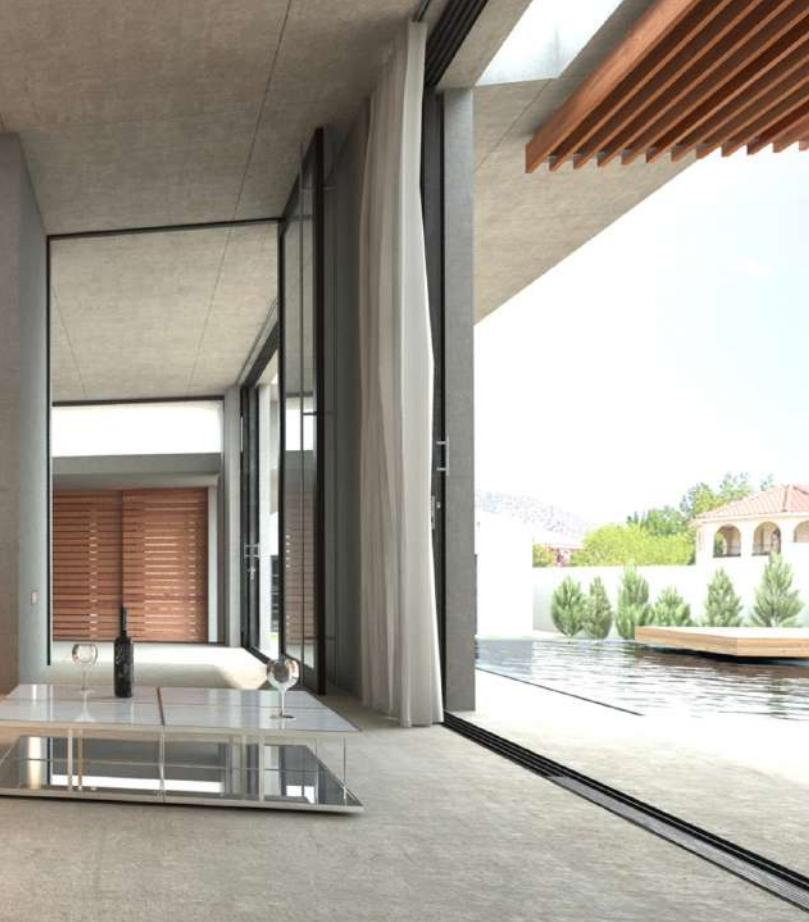
Zemine, tavana ve duvarların içine entegre edilen alüminyum çerçeveler dışarıdan minimum seviyede görünür. Pencere kapalı durumdayken görünen profil genişliği 20mm olan sürme profilinin ince ve zarif görünümü manzaraya geniş yer ayırır.
